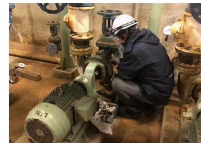
維持管理業者による修繕
